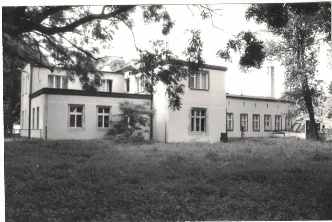
4. Ogrodowa elewacja dworu
